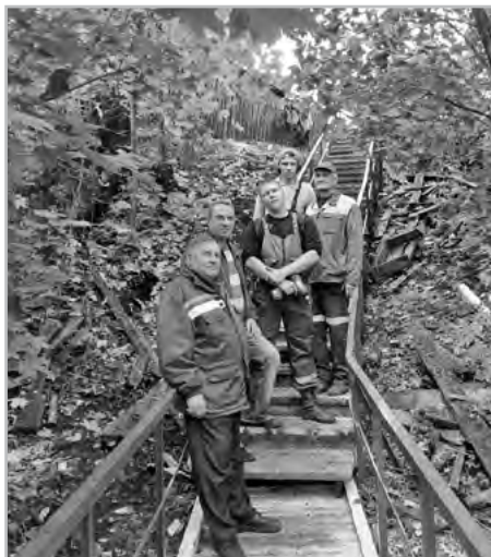
Бригада МПБО-2 на ремонте моста в переулке Трудовом
